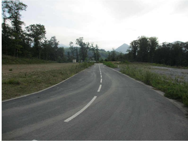
Fig. 11. La voie de desserte interne à la zone artisanale
